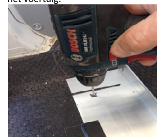
(11) Boor één gat met boor 2 of 3 mm en controleer dit aan de onderzijde. Bepaal vanuit dit punt de andere montagepunten.
