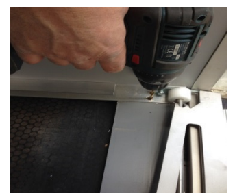
(15) Zet de kast aan de voorzijde vast met M8 bouten, ringen en moeren en wees daarbij attent op de beschikbare ruimte aan de onderzijde.
