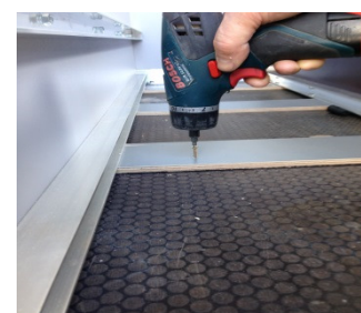
(15) Indien de kast aan de voorzijde niet kan worden vastgezet met M8 bouten, kunt u er voor kiezen de kast met schroeven in de vloer vast te zetten (niet aanbevolen).
